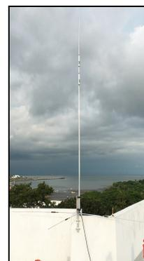
L'antenna con radiali rigidi può essere installata a qualsiasi altezza. La versione con radiali filari avrà prestazioni migliori se installata 10-20 cm sul terreno con radiale sul suolo o sul tetto.
